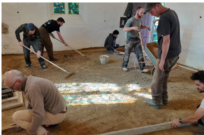
Préparation du sol avant une pilerie, Guimaëc ©Aline Benvegna Dos Santos - Tiez Breiz
