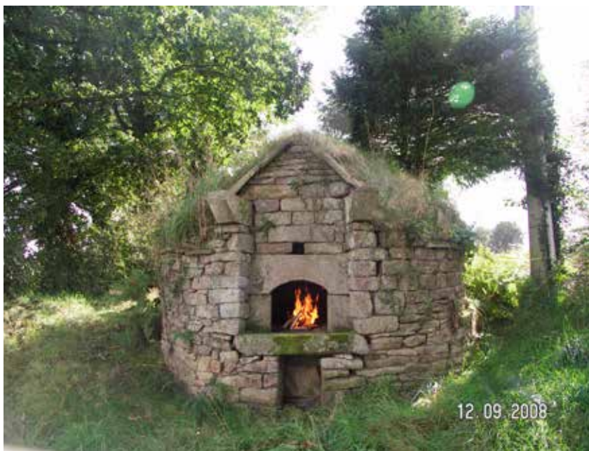
Four de Kergariou à Mellac
